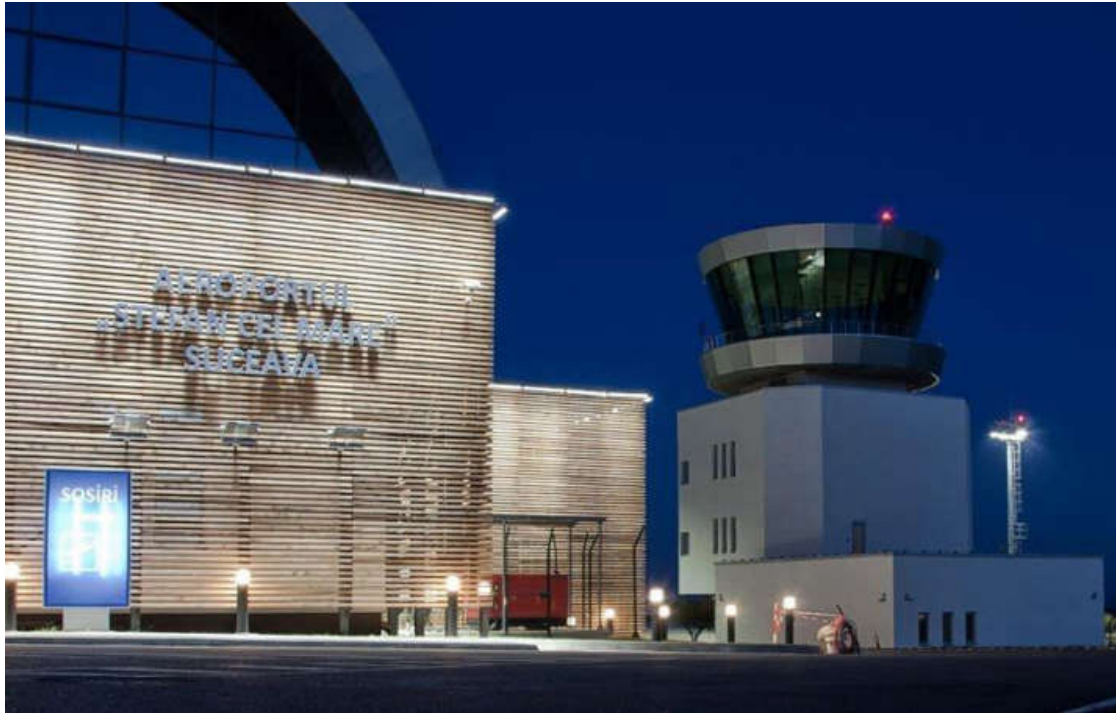
Figura 2.5.39. Terminalul Aeroportului Internațional Suceava
