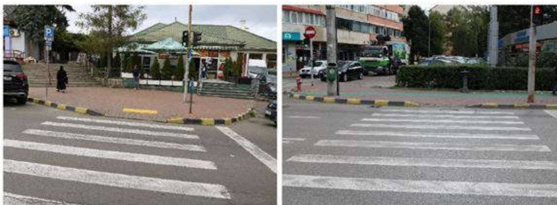
Figura 2.5.53 Treceri de pietoni accesibilizate (exemplificare)
