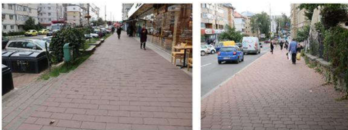
Figura 2.5.50 Trotuare modernizate (Exemplificare)
