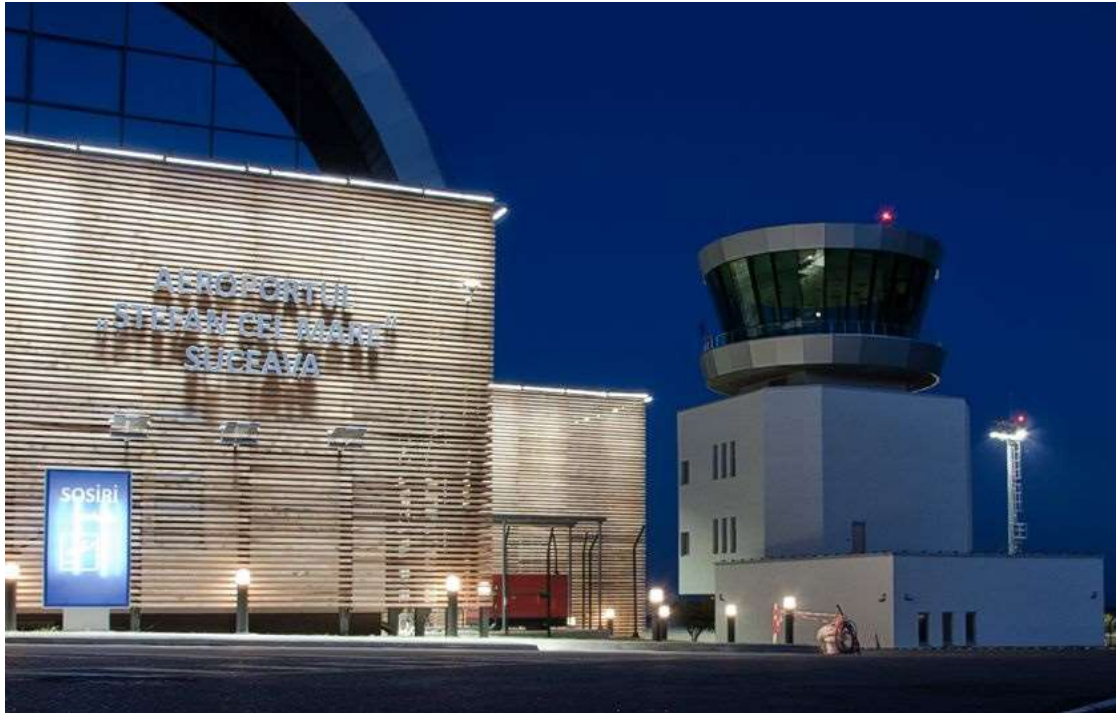
Figura 49. Terminalul Aeroportului Internațional Suceava
