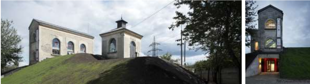
Figura 15. Uzina de Apă Suceava – Centrul de arhitectură, cultură urbană și peisaj.
