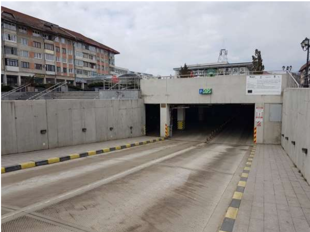
Figura 36. Parking subteran în Suceava
