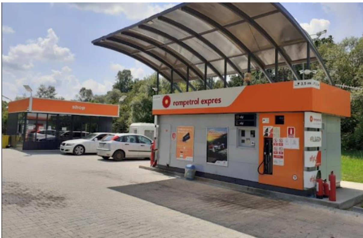
Exemplu stație Rompetrol EPXRES (similară cu cea care va fi montată prin proiect)
