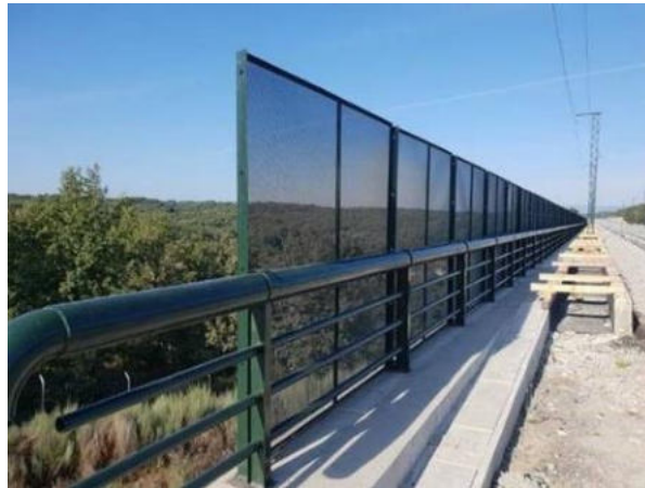
Figura nr. 2-5 Exemplu de panouri anticoliziune
