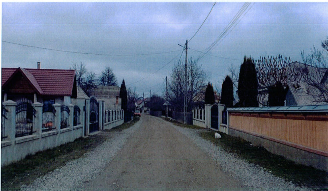
FOTO 8 - DRUM STR. BUTNĂRENILOR
