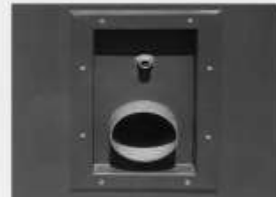
Instalație pentru apă și scurgere.
