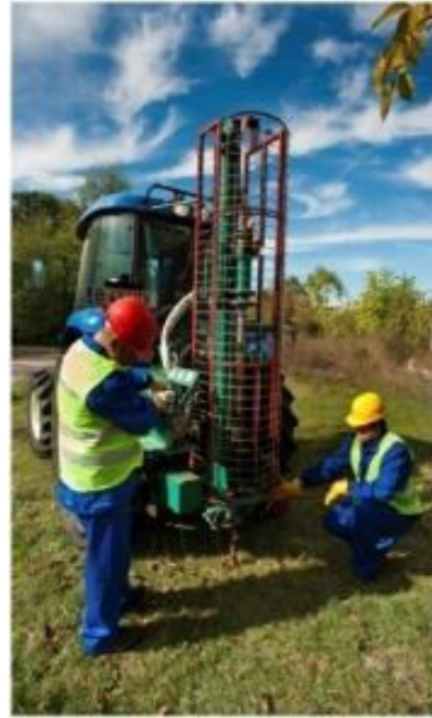
Fig. 7: Realizarea mecanică a găurilor
