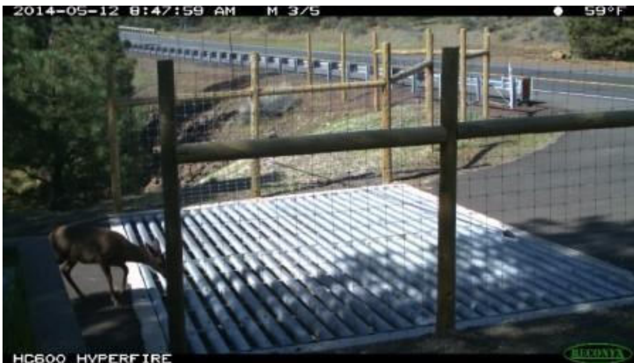
Figura nr. 7-3 A. Exemplu al unui grilaj electricizat pentru fauna sălbatică; B Exemplu al unui panou de avertizare montat pe un drum din Țara Galilor pentru a atenționa șoferii cu privire la prezența unui grilaj; C. Grilaj instalat pentru a evita pătrunderea faunei sălbaticice pe carosabilul unui drum din Washington, SUA
