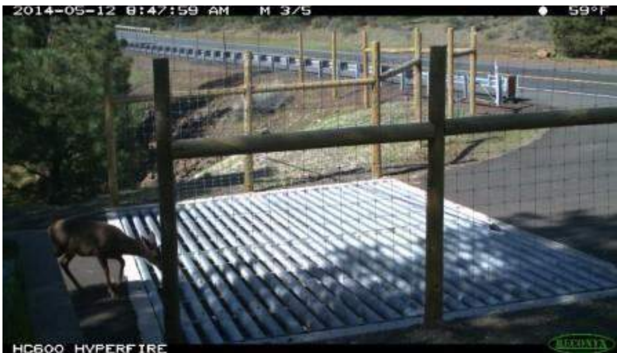
Figura nr. 7-3 A. Exemplu al unui grilaj electricizat pentru fauna sălbatică; B Exemplu al unui panou de avertizare montat pe un drum din Țara Galilor pentru a atenționa șoferii cu privire la prezența unui grilaj; C. Grilaj instalat pentru a evita pătrunderea faunei sălbaticice pe carosabilul unui drum din Washington, SUA
