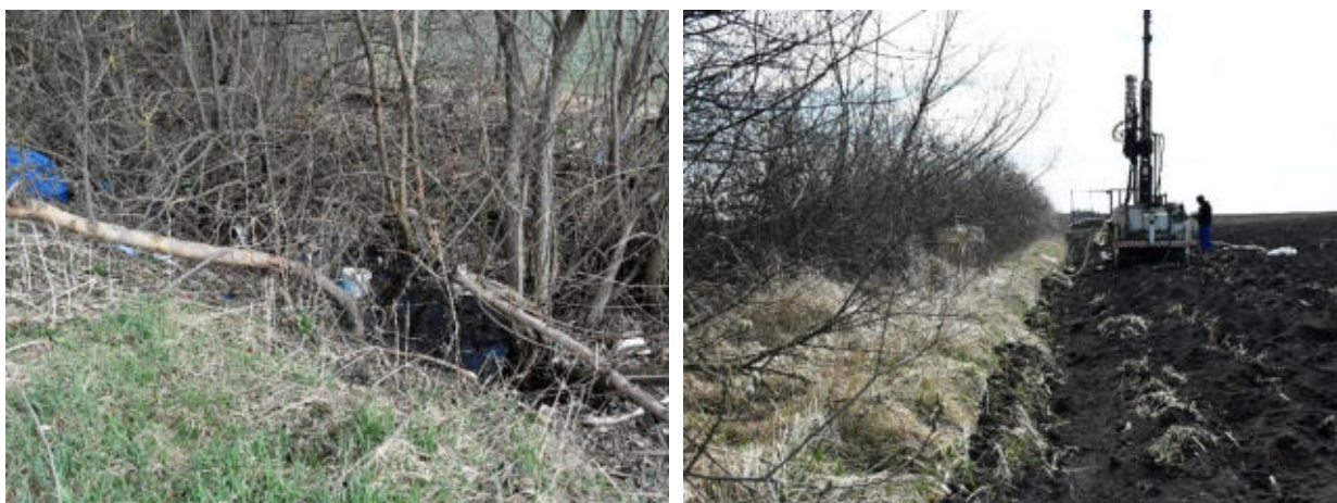
Figura nr. 5-38 Aspecte ale vegetației din zona de intersecție a proiectului cu pârâul Negostina, în zona km 42+000 – km 42+200
