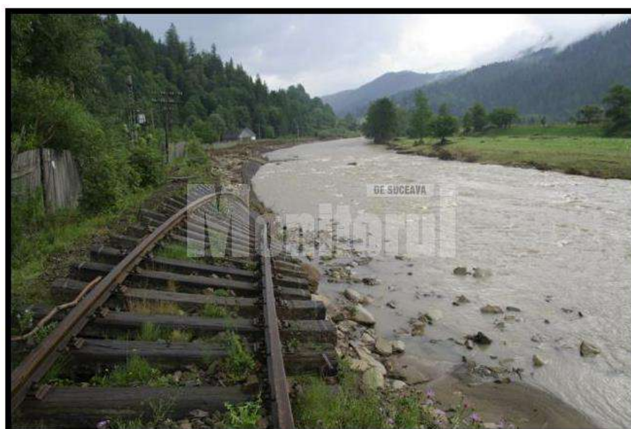
Terasament cale ferată pe sectorul superior al văii Suceava
