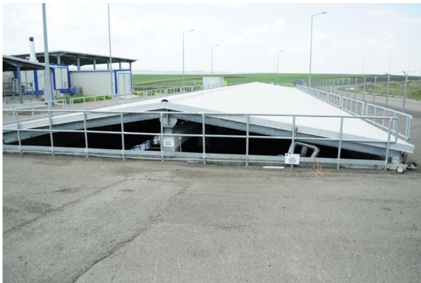
Fig.23. Bazinul tampon levigat și bazinul de admisie
