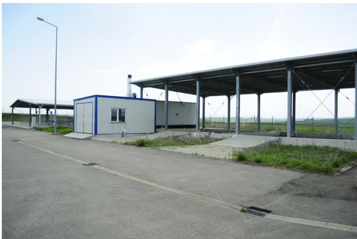
Fig.29. Containerele tehnologice și paturile de uscare
