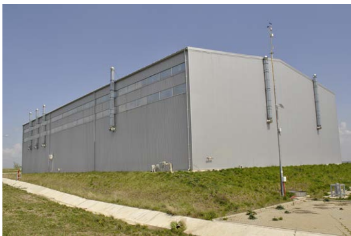
Fig. 2 Clădirea stației de sortare
