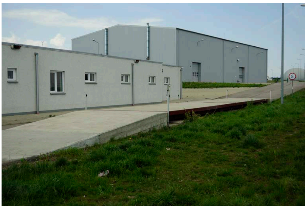
Fig. 18. Clădirea administrativă și platforma cântar
