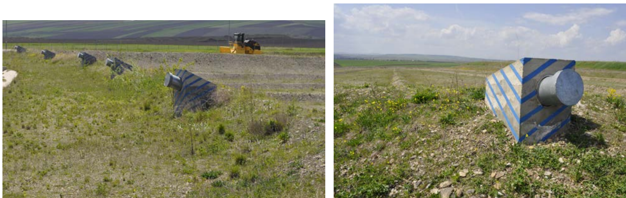
Fig. 1. Capătul conductelor de drenaj al levigatului
