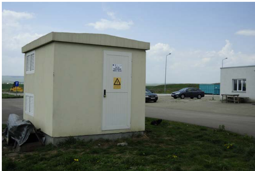
Fig.22. Postul de transformare
