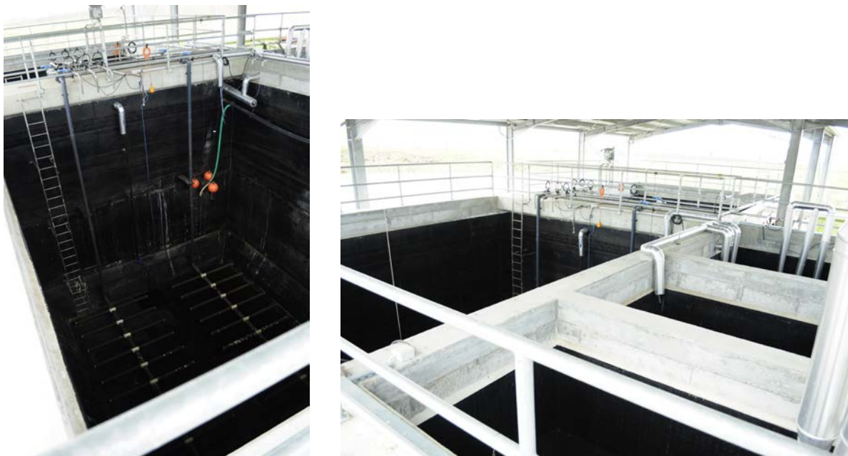
Fig.26. Bazinele SBR, de precipitare chimică, intermediar și de evacuare
